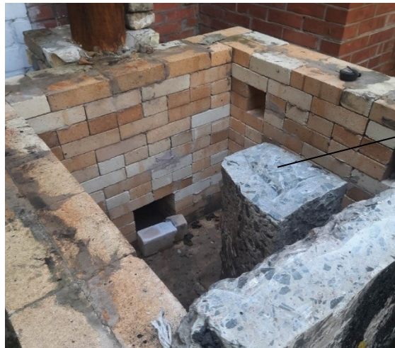
Рисунок 1 – Малогабаритний фрагмент залізобетонної балки, виготовленої заздалегідь до випробування: 1 фрагмент заздалегідь виготовленої залізобетонної балки.
